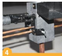
4 Termokaynak Pota Penssesini kapatarak Termokaynak Potasının tamamen birleşmesini sağlayınız.
