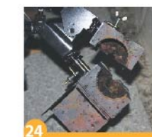
24 Pota Penssesini açarak kalıbı kaynaktan ayırınız.
