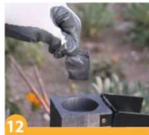
12 Çok az miktardaki Ateşleme Tozunu Termokaynak Potası içindeki Termokaynak tozu üzerine boşaltınız ve ateşleme tozunun bir miktarını da pota kenarına kadar dökerek işlemi tamamlayınız.
