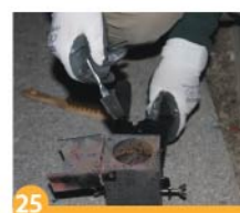
25 Yeni bir kaynak için potayı fırçasıyla temizleyiniz.
