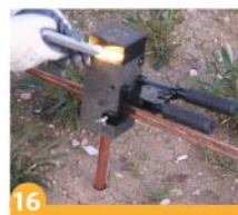
16 Termokaynak Ateşleme Tozunu , Termokaynak Çakmağı ile ateşleyiniz.
