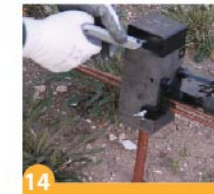
14 Termokaynak Ateşleme Tozunu , Termokaynak Çakmağı ile ateşleyiniz.
