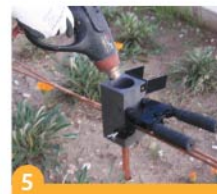
5 Elektrikli ısıtıcınız var ise potanın içini ısıtıp kaynak için ön hazırlık yapınız.
