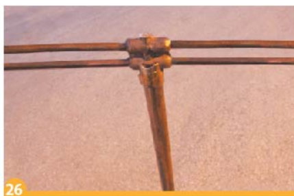
Tamamlanmış Termokaynak eki.
