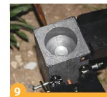
9 Termokaynak tozunu pota içine boşaltınız.
