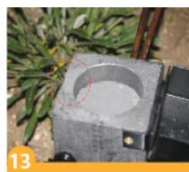
13 Termokaynak işlem için hazırdır.
