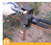
15 Termokaynak Ateşleme Tozunu , Termokaynak Çakmağı ile ateşleyiniz.
