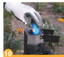
10 Termokaynak tozunu tamamen pota içine döktükten sonra kutunun arkasıyla tozu düzeltiniz.
