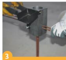
3 Eklenecek olan diğer Topraklama İletkenini de pota içine yerleştiriniz.
