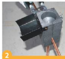
2 Topraklama Elektrodu ve Topraklama İletkenini pota içine yerleştiriniz.
